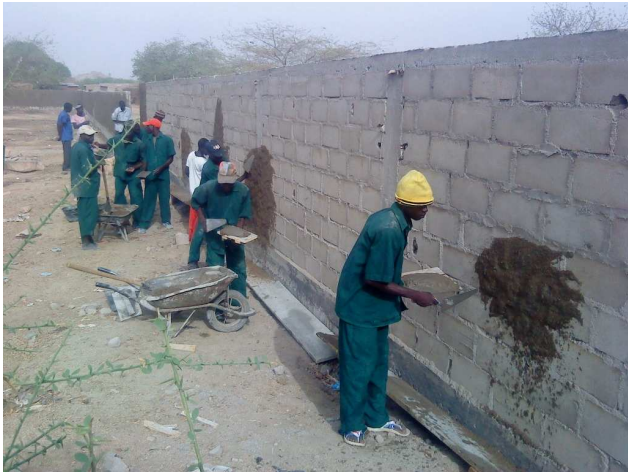
Formation des apprentis maçons lors de la construction du mur d'enceinte
